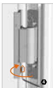
Untere Verstellspindel bei allen Bändern ein-drehen.
