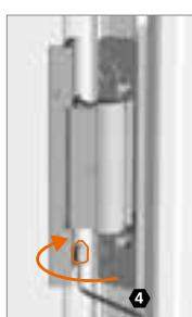
Untere Verstellspindel bei allen Bändern ein-drehen.
