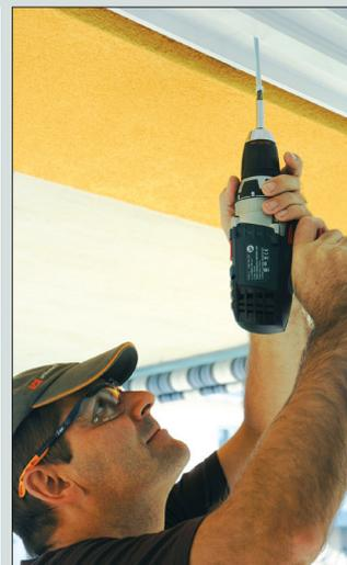
**4.** Drehen Sie die beige-packte Innen-Sechskantschraube mit der Scheibe ein. Nivellieren Sie die obere Weite. Stecken Sie die Abdeckkappe auf.
